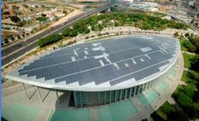
Cubierta de 8.000 m2, con claraboyas y exutorios. Y láminas fotovoltaicas integradas, con una potencia útil de 256 kw. Ensayo de instalaciones singulares, sobre todo orientadas a la sostenibilidad. La cubierta del edificio incorpora una instalación de 2.100 módulos instalados en paneles fotovoltaicos, la mayor registrada en un edificio de estas características, que ya ha generado un acumulado de más de 3,4 millones de kWh.
