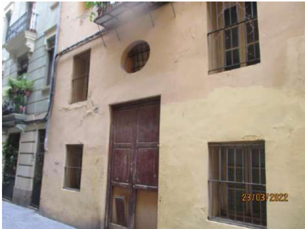
Accés al local des de C/ Torn de l'Hospital
